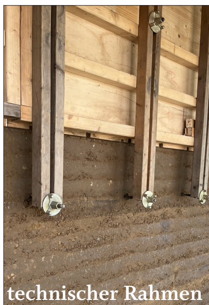
Abb. 3: Stampflehmwand in Bau
